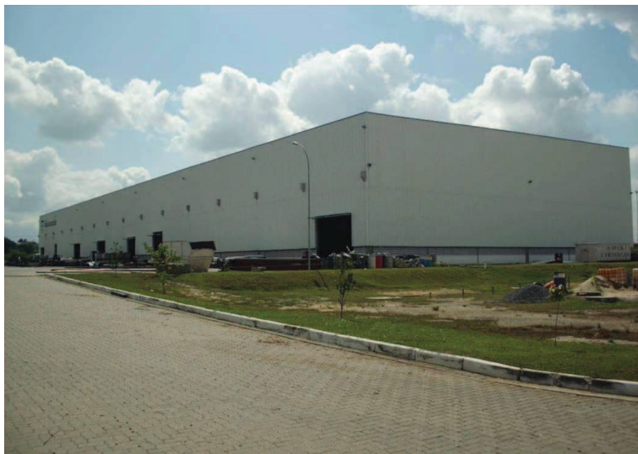
Vista geral frontal do imóvel avaliando.
