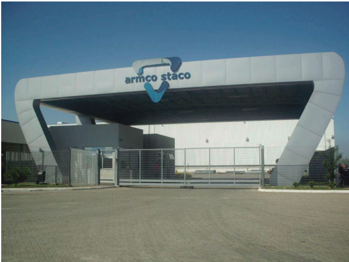
Aspectos da portaria de acesso.
