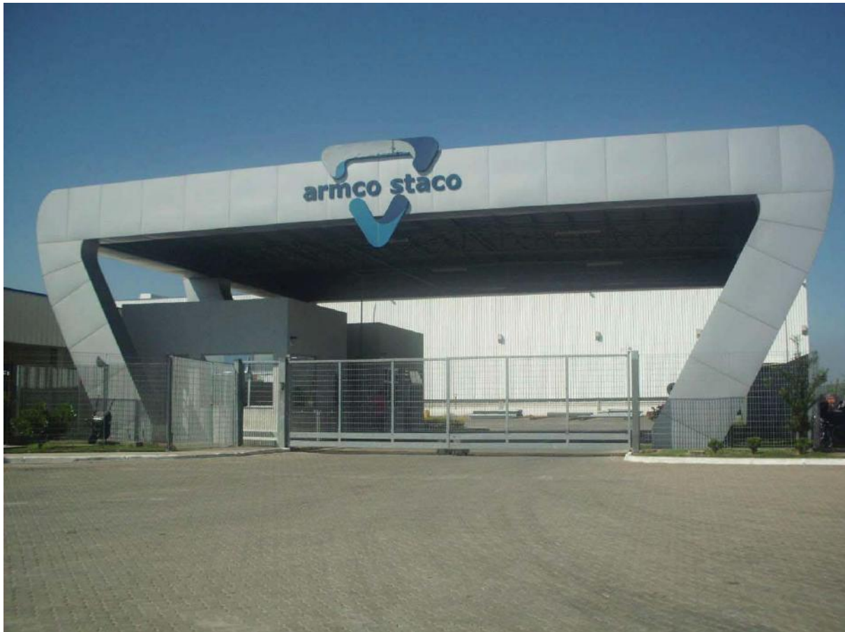
Aspectos da portaria de acesso.
