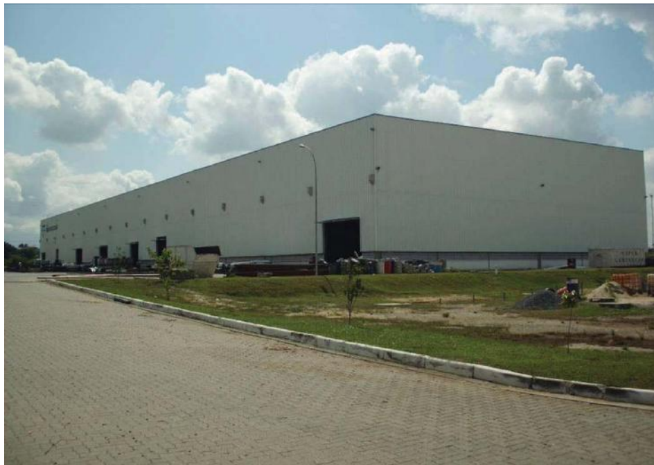
Vista geral frontal do imóvel avaliando.
